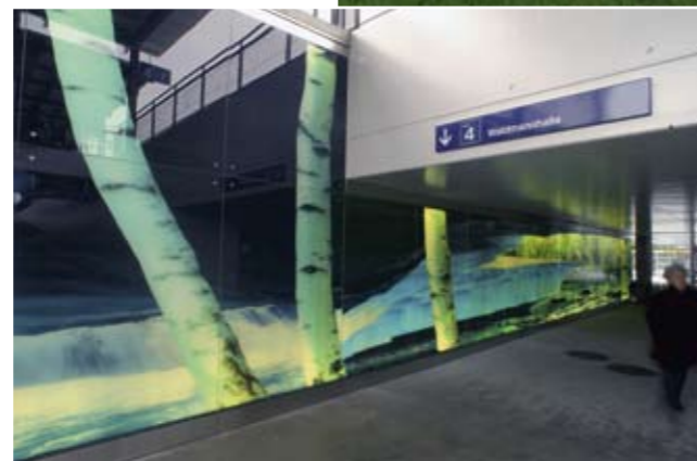
Beständigkeit und gleichbleibende Farbbrillanz. 150m 2 grosse Glaslichtwand in der S-Bahn-Unterführung Baar – seit über vier Jahren im Einsatz.
